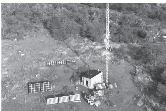
Realizamos **inversiones en más paneles solares** para proveer energía en los sitios y de esta manera, ahorrar en combustible y mantenimiento de motores.
